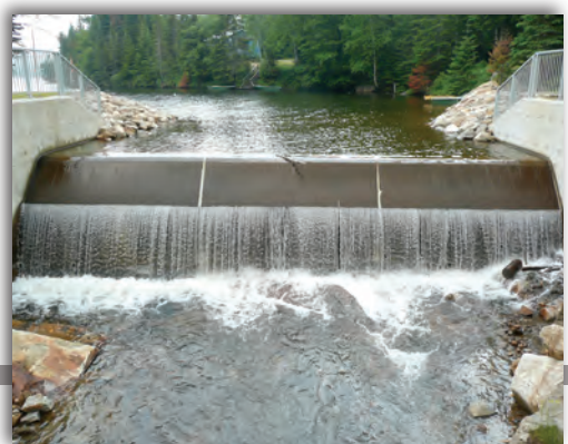
▼ Déversoir libre en béton
