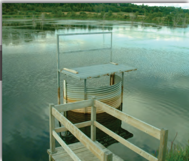
▲ Déversoir muni d'un grillage protecteur
