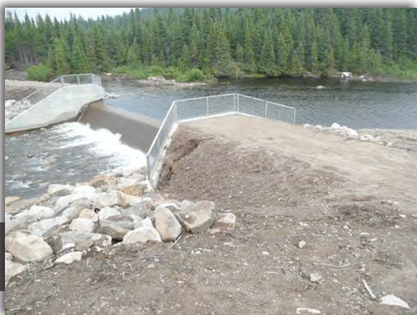
◀ Déversoir à seuil fixe
