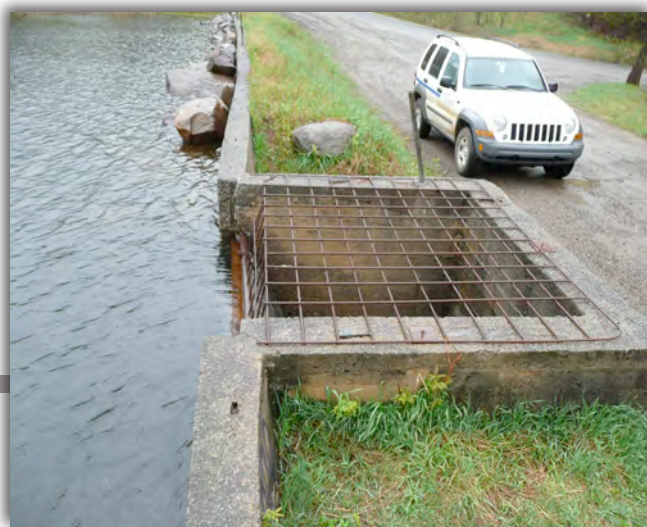
▲ Déversoir muni d'un grillage protecteur
