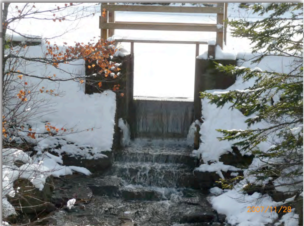
Déversoir sans mécanisme de levage ▼
