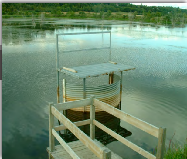
▲ Déversoir muni d'un grillage protecteur
