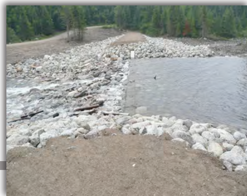
▼ Déversoir en enrochement
